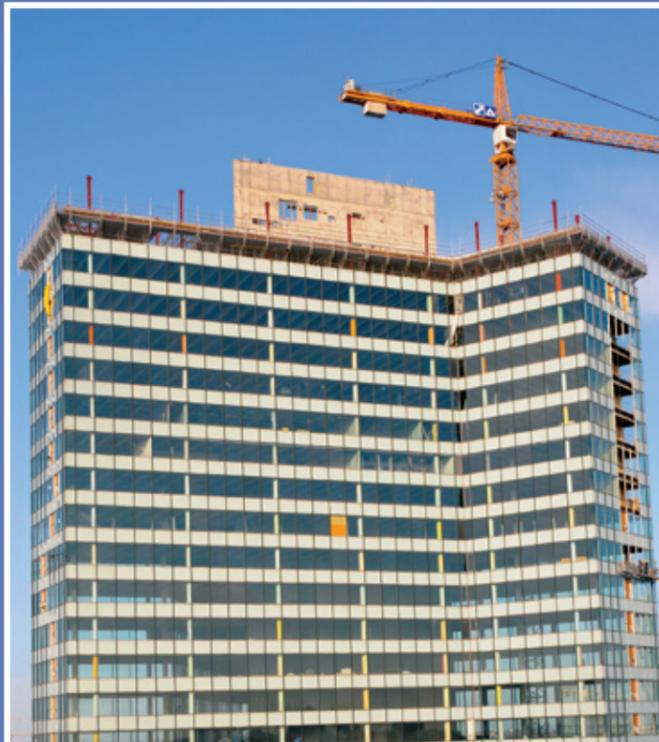
Das Hochhaus wurde bereits vollständig entkernt; die Aufstockung um zwei Etagen ist in vollem Gange
